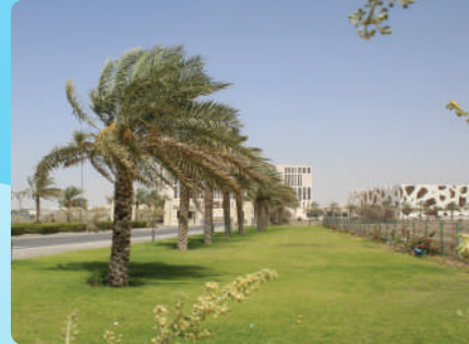
محطة تحلية مياه للجامعة الألمانية للتكنولوجيا RO plant for German University of Technology
