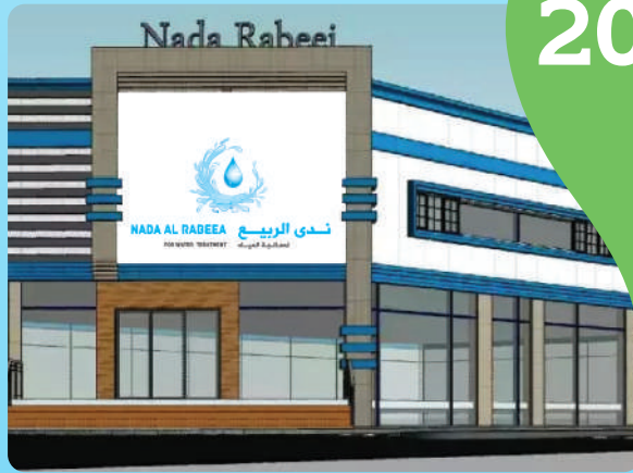
إفتتاح مصنع ندى الربيع لمعالجة المياه قريبا Opening of Nada Al Rabeei Factory soon
