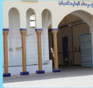
محطة تحلية مياه لمصنع الحلوى العمانية RO plant for Omani Halwa Factory
