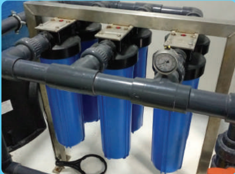
مشروع محطة تحلية مياه في صحار RO plant project in Sohar
