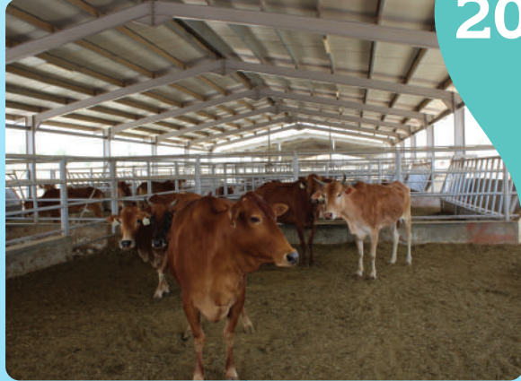
أحد المشاريع لوزارة الزراعة بعد تركيب محطة تحلية المياه One of Ministry of Agriculture projects after making RO PLANT
